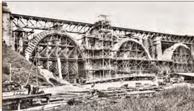
Železniční most v Dolním Krnsku podle projektu S. Bechyněho – výstavba a dnešní stav
