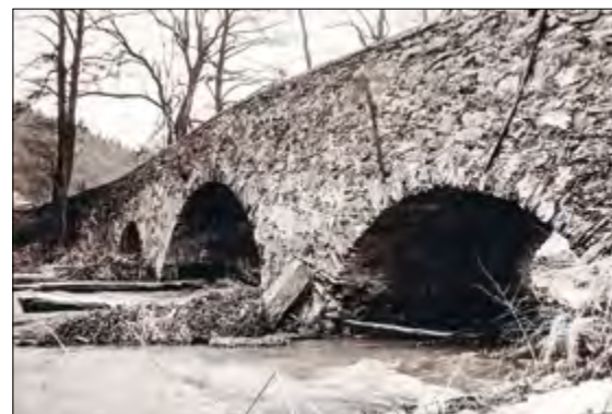
Součástí historických cest jsou mosty, které mnohdy stojí na stejných místech po staletí. Na fotografii most v Ronově nad Sázavou
