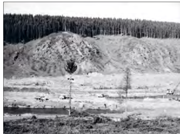
Budování přehrady na Želivce
